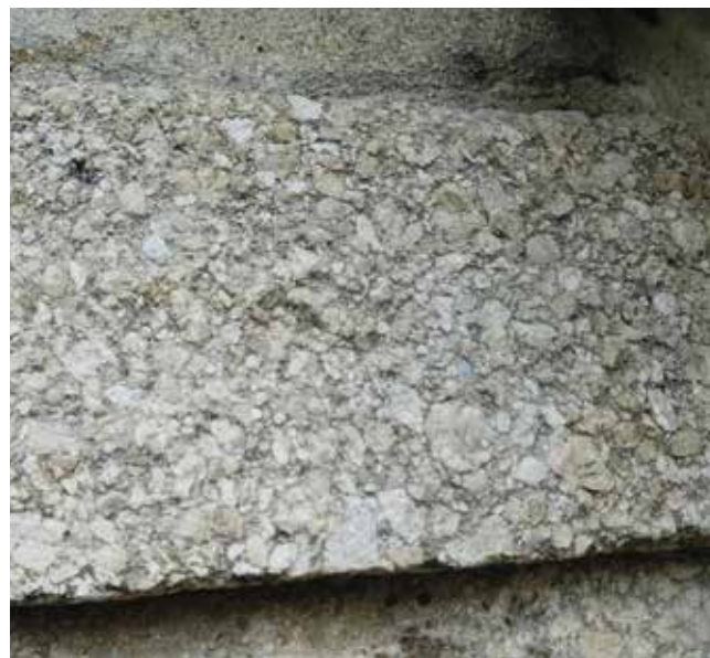
Particolare del portale in cui si riconosce la grana piuttosto grossa della roccia.
