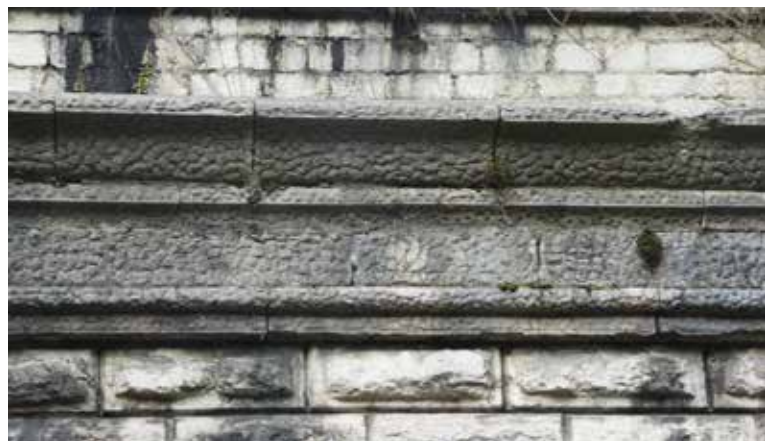
Particolare della costruzione.
