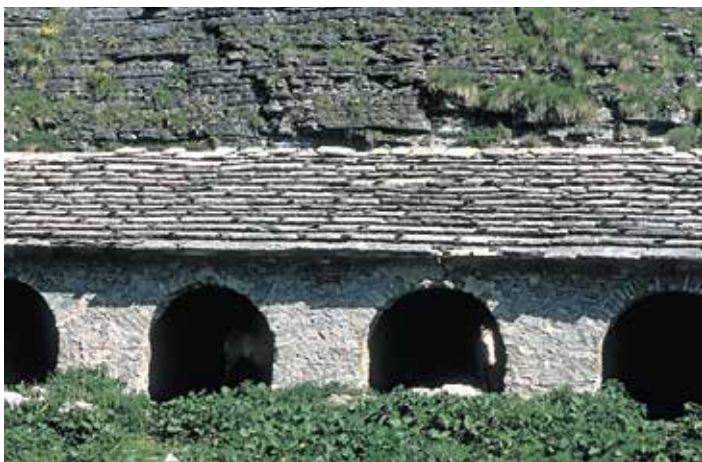
La "pendana" di Brendol con la copertura a lastame.
