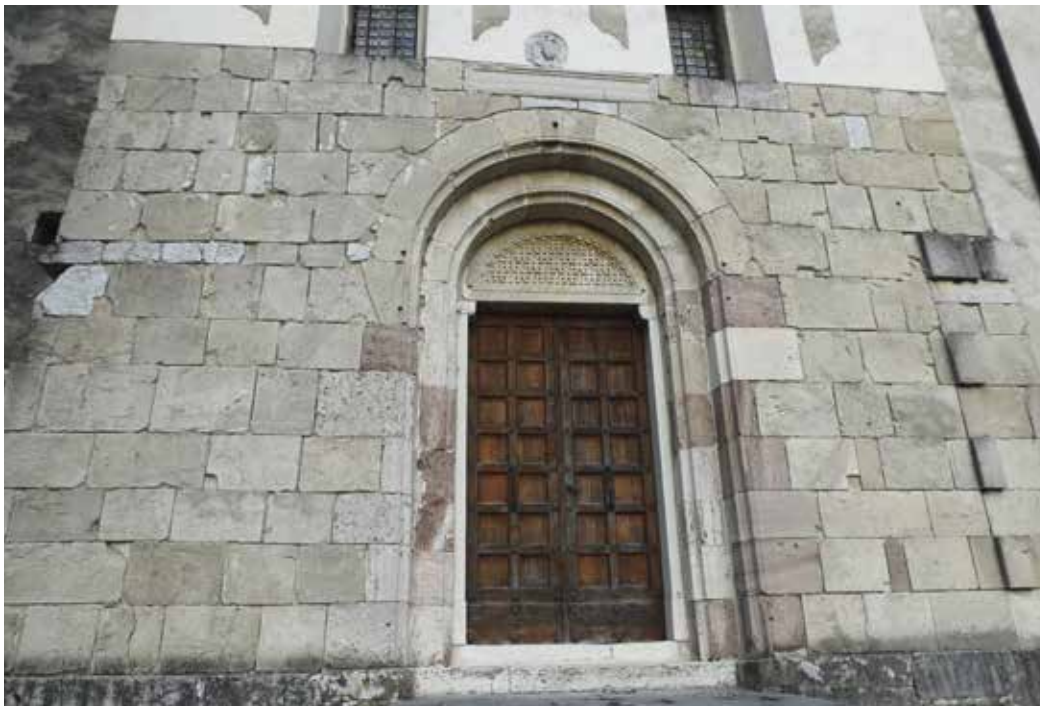
Facciata del santuario dei Santi Vittore e Corona (Anzù) costruito con conci lapidei squadrati di calcare del Vajont dolomitizzato, per la realizzazione del portale sono stati impiegati anche elementi di Scaglia Rossa (Lastame).
