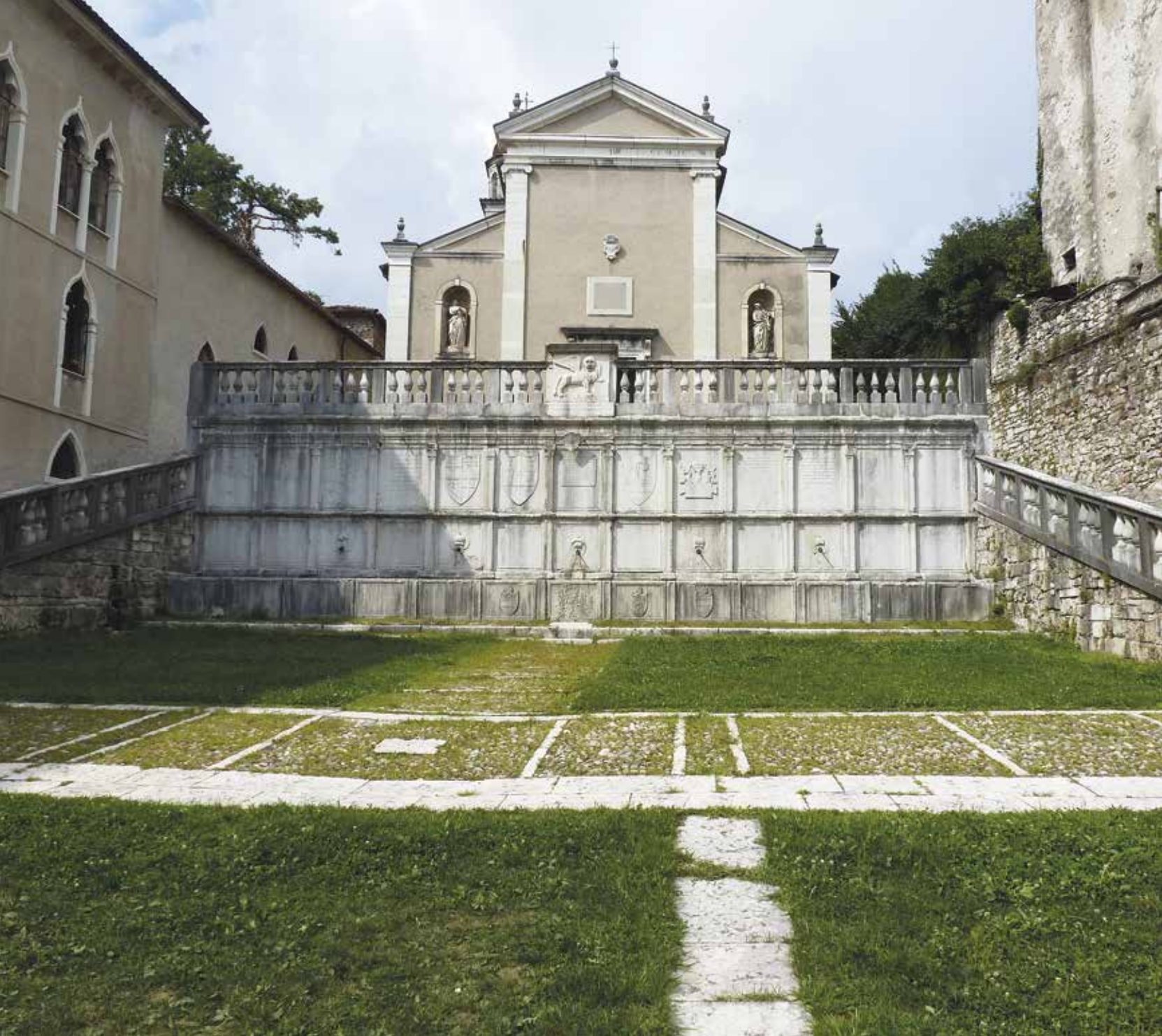
La chiesa di San Rocco e le Fontane Lombardesche realizzate in Totoniano Bianco, lateralmente, a tamponamento delle scale, è stato utilizzato del travertino.
