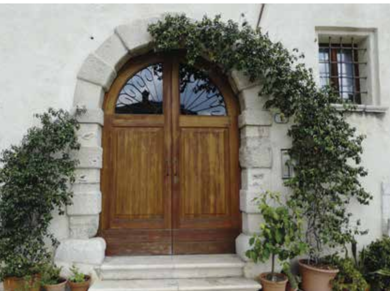
Casa Angeli in Piazzetta Filippo de Boni, portale costruito con conci lapidei della Calcarenite di Col Balcon.
