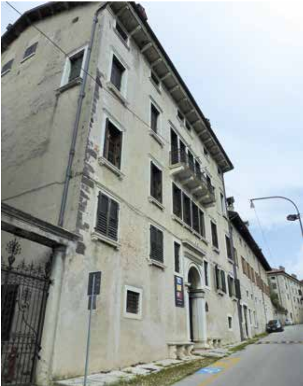
Palazzo Cumano (ora Galleria Rizzarda) in Via del Paradiso. Anche in questo caso gli elementi architettonici decorativi sono in Titoniano Bianco, si evidenzia che per le pietre d'angolo sono stati impiegati conci di porfido.
