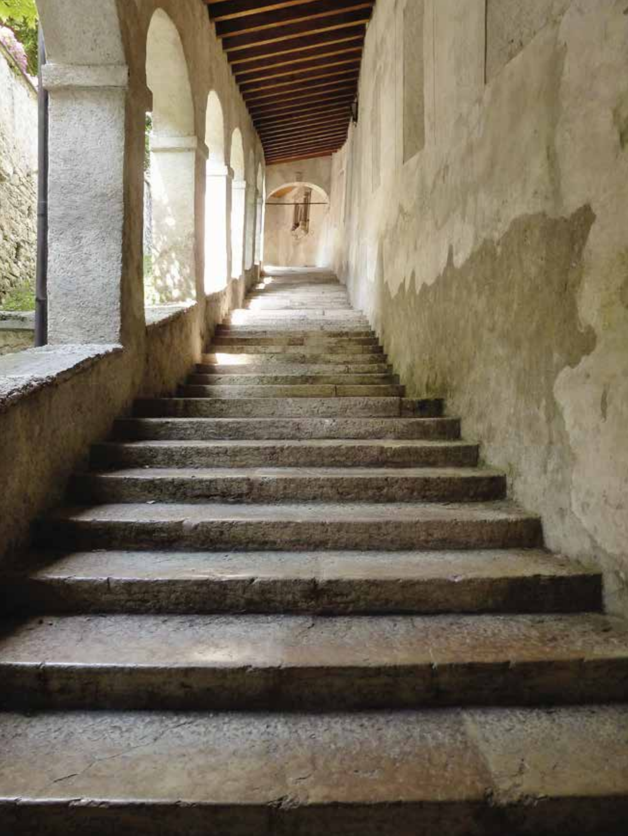
Scalette Vecchie (1497-98) realizzate principalmente in Scaglia Rossa varietà Lastame.
