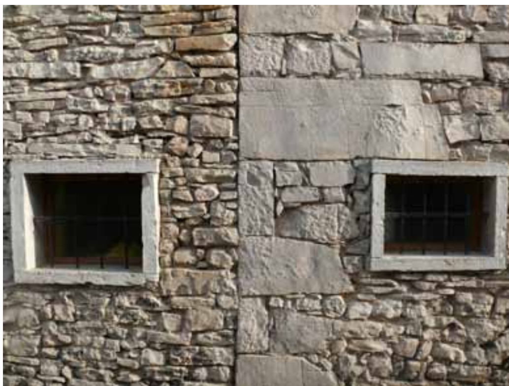
Particolari di fori finestra e tessitura muraria a Cugnan di Ponte nelle Alpi
